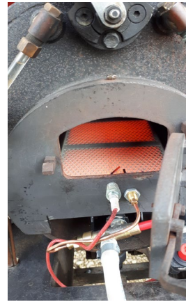
Vue du foyer en chauffe.
